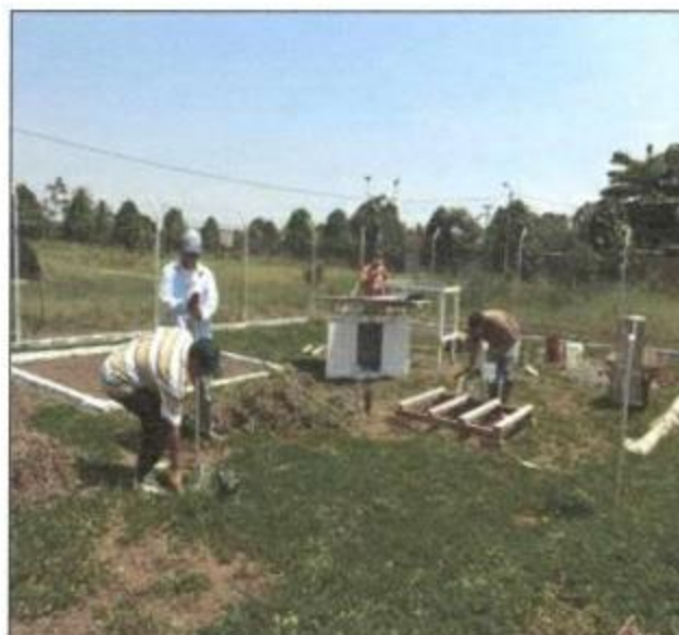
Reinstalación de la CP Tocache
