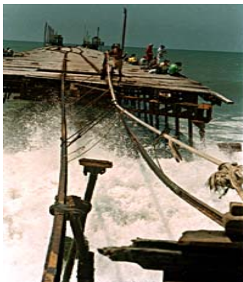
Colapso de una parte del Muelle de Puerto Etén por maretaos. Lambayeque
