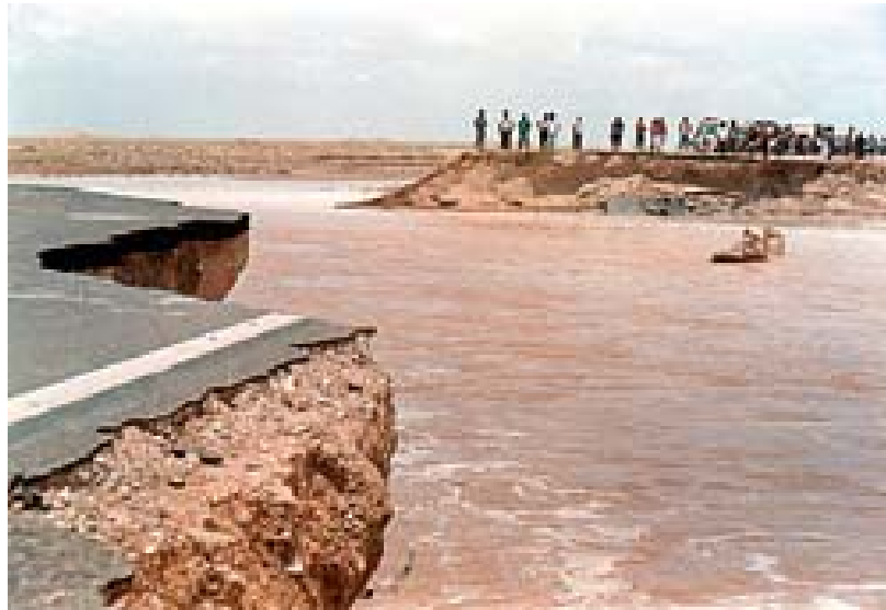
Colapso del km 822 de la Panamericana norte por acción del río La Leche
