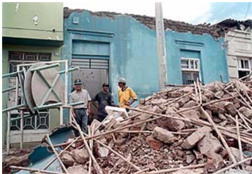
Dstrucción de vivienda en el centro de Chiclayo por intensas lluvias
