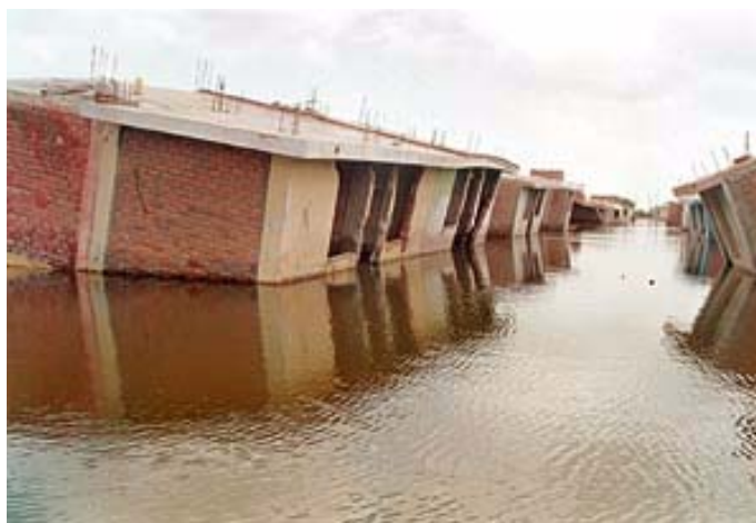
Complejo habitacional “Mocce”, ciudad de Lambayeque, luego de las intensas lluvias e ingreso de antiguos torrentes
