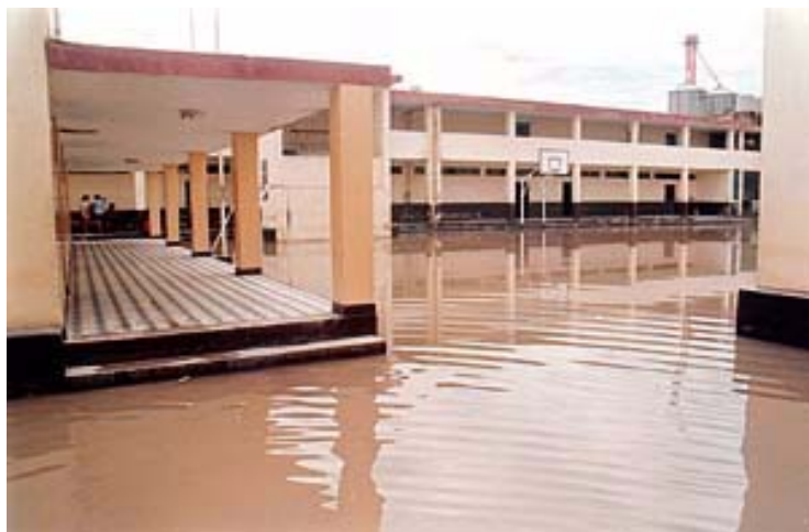
Colegio de Chiclayo inundado por excepcionales lluvias de febrero 1998
