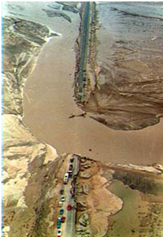
Vista aérea del km 822 de la Panamericana norte cortada por el río La Leche
