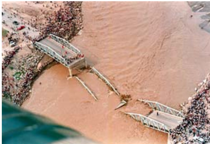
Vista aérea del Puente Reque, nótese la fractura de sus estructuras a la margen izquierda del río y a la margen derecha los pilares centrales
