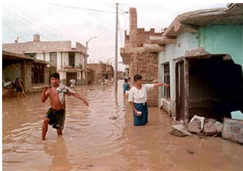
Calle de Chiclayo totalmente inundada luego de las lluvias del 14 - 15 de febrero 1998 y el colapso del sistema de alcantarillado. Se observa la abertura que abrió en una casa el torrente de agua y desagües
